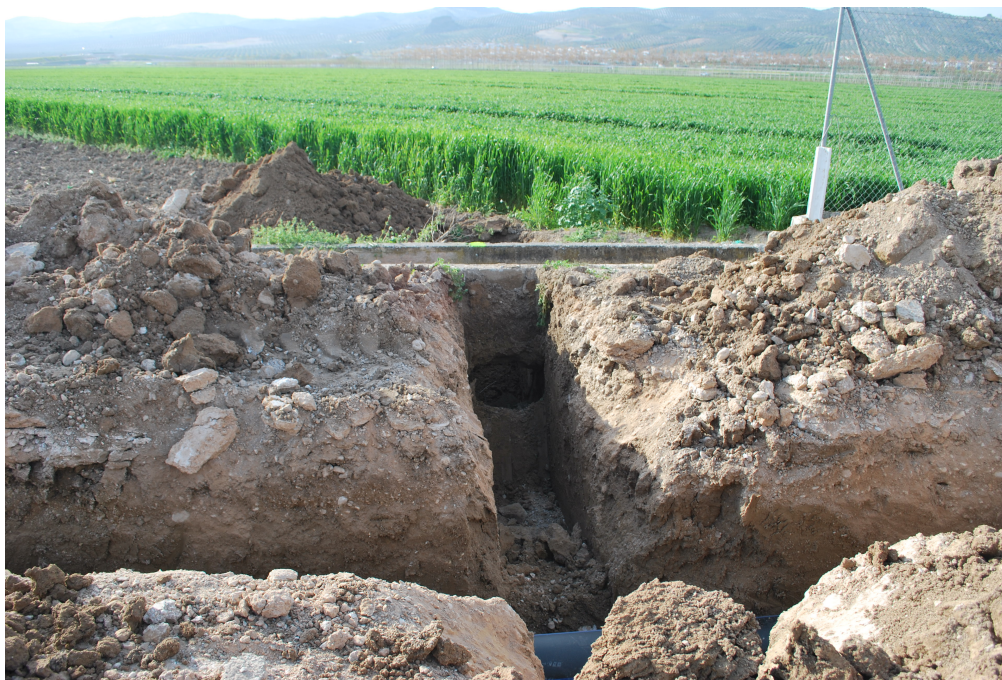
Las obras de modernización de un SHR a través de la sustitución de las acequias por una red de distribución de tuberías subterráneas
